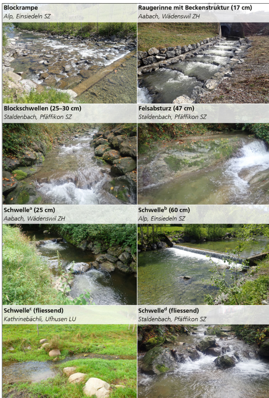
Bild 5: Die vier Wirkungskontrollen zur Überprüfung der Fischgängigkeit an Aabach (Wädenswil, ZH), Alp (Einsiedeln, SZ), Kathrinebächli (Ufhusen, LU) und Staldenbach (Pfäffikon, SZ) untersuchten ein Raugerinne mit Beckenstruktur, eine Blockrampe, eine Rampe mit Blockschwellen sowie diverse Schwellen und Abstürze.
