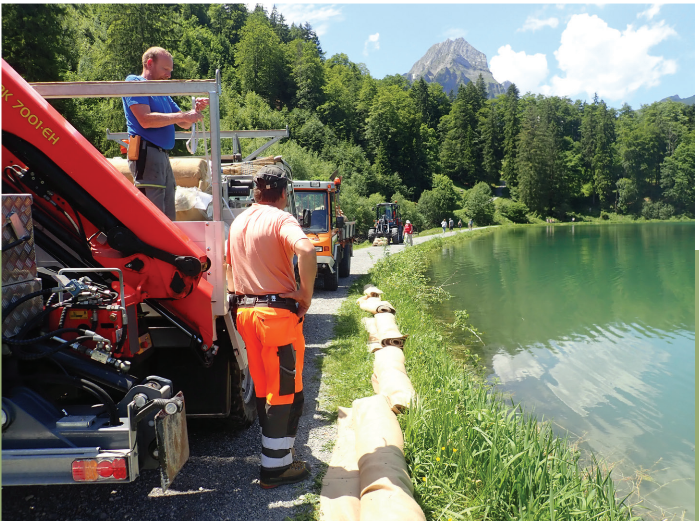
Les rouleaux de jute sont prêts pour la mise à l'eau (photo: AquaPlus).
