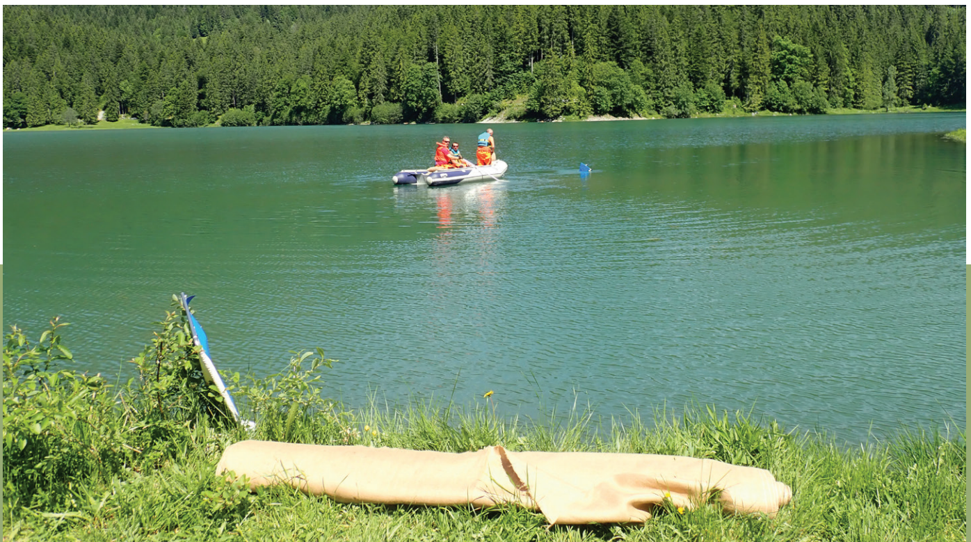
Les sacs de gravier étaient fixés à une corde pour les faire descendre de la barque jusqu'au fond de l'eau où ils étaient pris en charge par les plongeurs (photo: AquaPlus).
