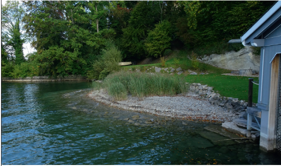
Abb. 3: Beispielansicht einer Seeuferaufwertung unter den «typischen» Rahmenbedingungen zur Anwendung des «PRAKTIK»-Modus' [u.a. kleiner Uferabschnitt, Privatgrundstück, Interventionsraum landseitig beschränkt, keine übergeordnete Planung, Umsetzung lokaler Ersatzbedarf], Szenario «INTERMEDIA, Landabtrag und Schüttung zur Ausbildung einer Wasserwechselzone ca. 1:10, mit seeseitigem «Steindamm», bis zum Aufkommen dichter Unterwasservegetation, zusätzlich partielle (Wieder-)Ansiedlung von Schilf als Trittsteinbiotop. Der Beginn der terrestrischen Vegetation liegt am Fuss der landseitigen Steinbänkschung (Steilstufe bis Terrainhöhe). Von Juni bis August steht die Kiesfläche unter Wasser. Der Mittelwasserstand liegt etwa in der Mitte der Kiesfläche. Zeitpunkt der Aufnahme ca. 10 cm unter MW. Foto: AquaPlus, 4.10.2016, 3 Jahre nach der Schilfpflanzung | Fig. 3: Vue d'exemple d'une revitalisation de rives lacustres dans les conditions cadres « typiques » pour l'application du mode « PRACTIQUE » [comprenant une petite section de rive, une propriété privée, une zone d'intervention limitée côté terre, pas de planification de niveau supérieur, mise en œuvre des exigences locales de remplacement], scénario « INTERMEDIA », enlèvement de terre et remblai pour la formation d'une zone de marnage d'environ 1:10, avec un « barrage de pierres » côté lac, jusqu'à l'émergence d'une végétation sous-marine dense, avec une (ré)implantation partielle supplémentaire de roseaux comme biotope-relais. Le début de la végétation terrestre se trouve au pied du remblai de pierre côté terre [marche raide jusqu'au niveau du terrain]. De juin à août, les bancs de gravier sont sous l'eau. Le niveau moyen de l'eau se situe approximativement au milieu des bancs de gravier. Moment de la saisie environ 10 cm en-dessous du niveau moyen de l'eau. Photo : AquaPlus, 4.10.2016, 3 ans après la plantation des roseaux
