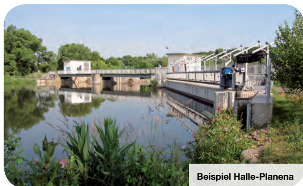
Abb. 1: Oberwasser mit Wehr und Fischabstiegsanlage.
